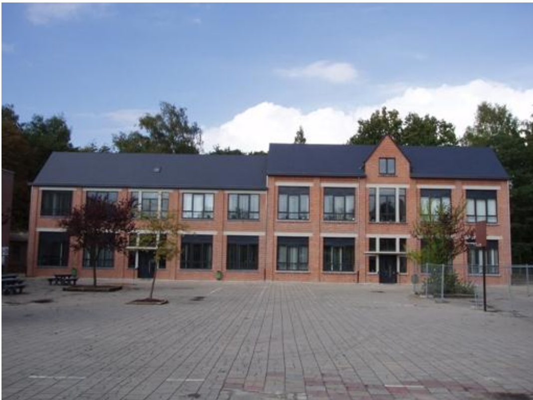
2006: de school na de renovatie
